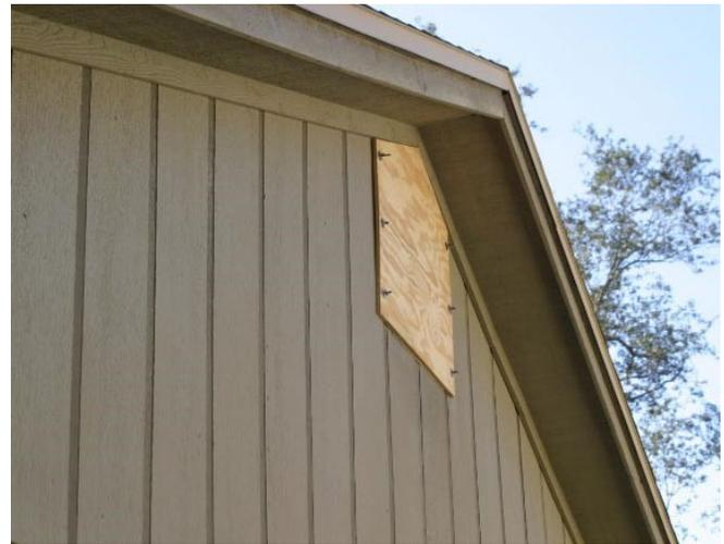
Figura 4.21: Postigos exteriores del respiradero de los extremos de los hastiales con madera contrachapada
