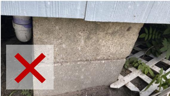
Figura 2.1: Cimientos apilados en seco no elegibles
