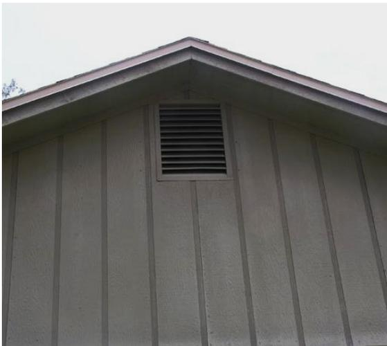
Figura 3.4: Ejemplo de respiradero de los extremos de los hastiales
