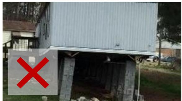
Figura 2.4: Cimientos apilados en seco no elegibles
