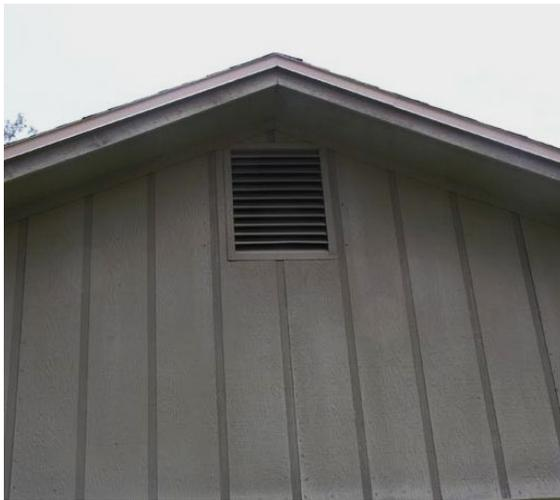
Figura 4.22: Ejemplo de respiradero de los extremos de los hastiales
