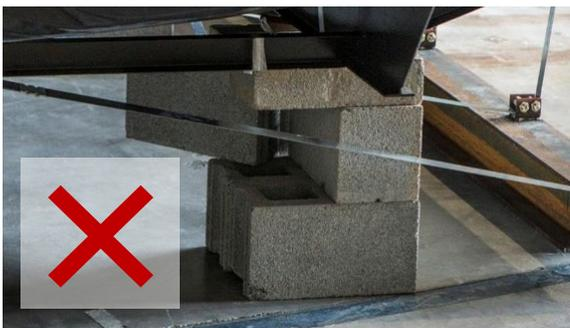
Figura 2.3: Cimientos apilados en seco no elegibles
