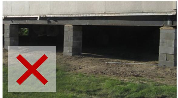
Figura 2.2: Cimientos apilados en seco no elegibles
