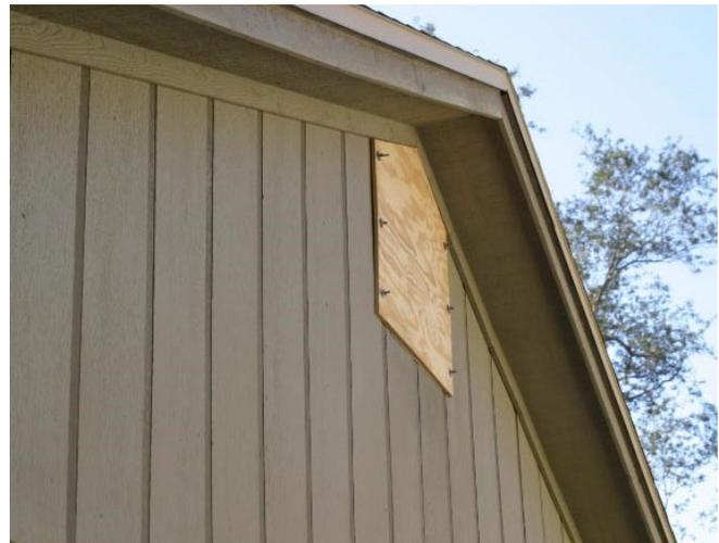
Figura 3.3: Postigos exteriores del respiradero de los extremos de los hastiales con madera contrachapada
