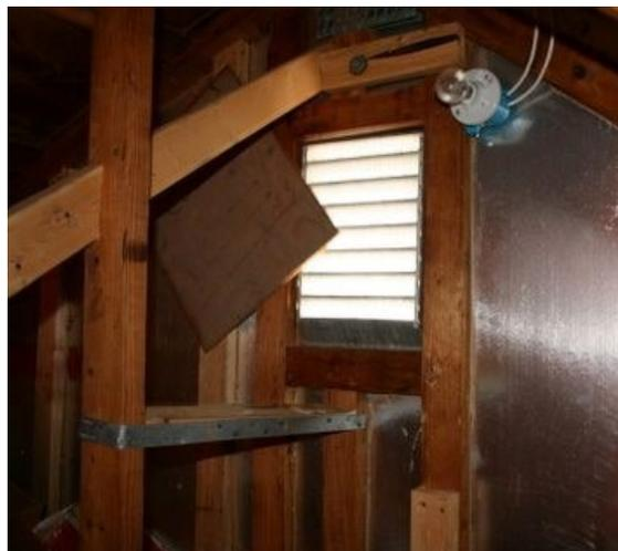
Figura 3.5: Postigos del respiradero de los extremos de los hastiales desde la parte interior del ático
