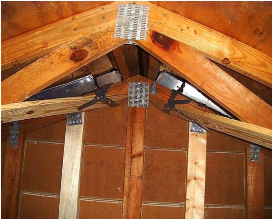
Figura 5.3. Bloqueo de los respiraderos de los soffitos del reborde de los hastiales con tapajuntas metálico
