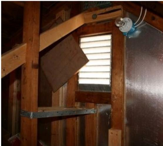
Figura 4.20: Postigos del respiradero de los extremos de los hastiales desde la parte interior del ático
