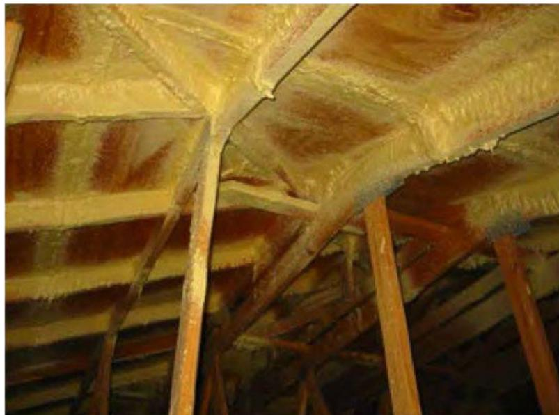
Figura 1. Adhesivo de espuma de poliuretano de celda cerrada aplicado a la parte inferior del revestimiento del techo en las juntas entre los paneles de revestimiento y a lo largo de todas las intersecciones entre el revestimiento del techo y todos los miembros de la estructura del techo.
