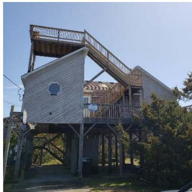
Figura 1: Plataforma con estructura de madera construida sobre el área del techo de una vivienda.
