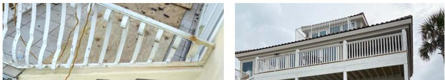
Figura 3: Plataforma con pisos cerámicos ubicada en un techo plano sobre un espacio habitable.
