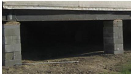
Figura 1. Cimientos apilados en seco no elegibles. No hay mortero visible entre los bloques.
