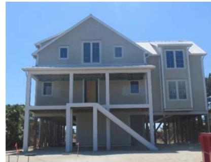
Figura 7. Postes y vigas o pilotes.
