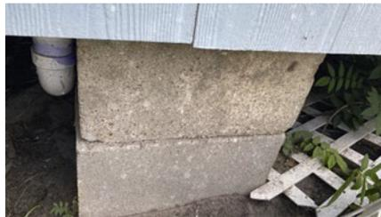
Figura 2. Cimientos apilados en seco no elegibles.
