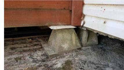
Figura 4. Cimientos apilados en seco no elegibles.
