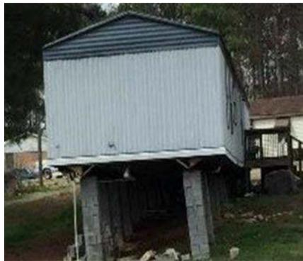
Figura 3. Cimientos apilados en seco no elegibles.
