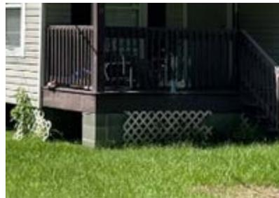
Figura 9. Postes y vigas o pilotes.
