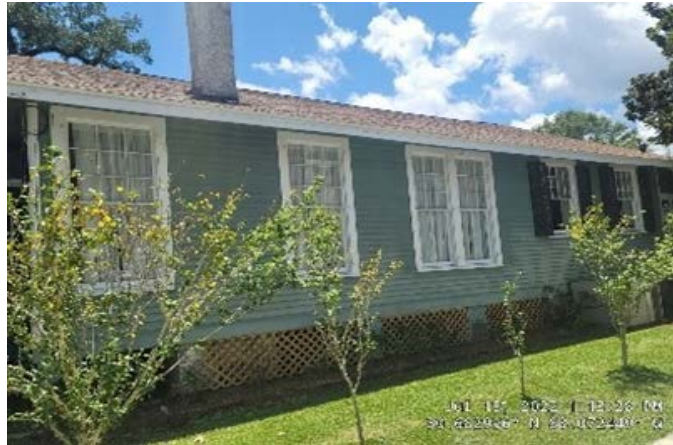
Figura 3: Ejemplo de zócalos de una vivienda construida según el código del HUD.
