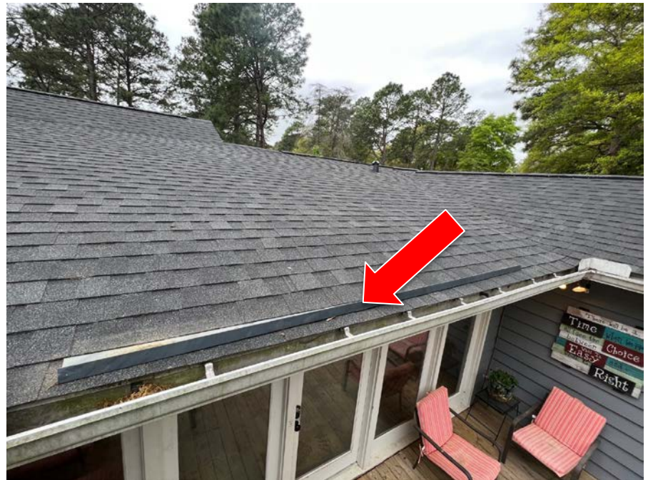
Figura 1: Ejemplo de un desviador de lluvia instalado en un techo de tejas asfálticas.
