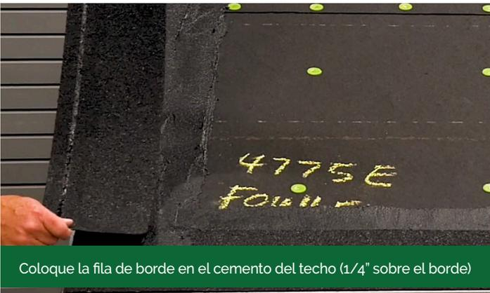
Coloque la fila de borde en el cemento del techo (1/4" sobre el borde)
